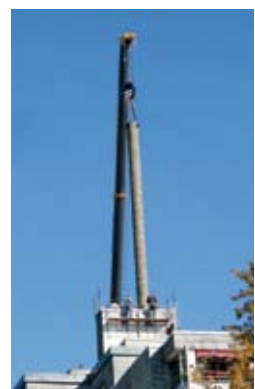
Einbringung des Innenrohrs in den 38 Meter hohen Kamin beim Fernheizwerk II
