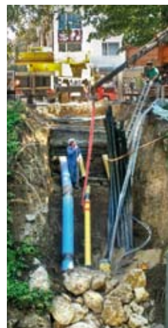
Kroatensteg – Sichern der Leitungen mit Flusssteinen und Betonplatten, um ein Aufschwemmen (Freispülung) zu verhindern
