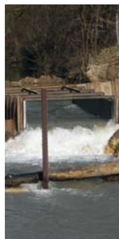
Rems – Wasserbrücke wird eingebaut – leitet Wasser um
