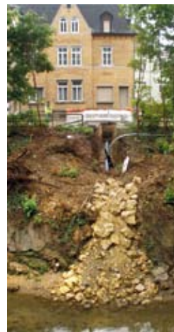
Karl-Olga-Brücke – Dükerbauwerk mit Blickrichtung Uferstraße
